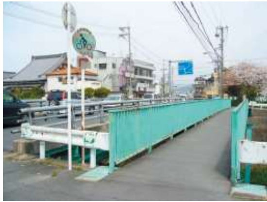
写真4. 逢合橋 もともとの橋の南北に色の異なる歩道橋が追加工事されました
