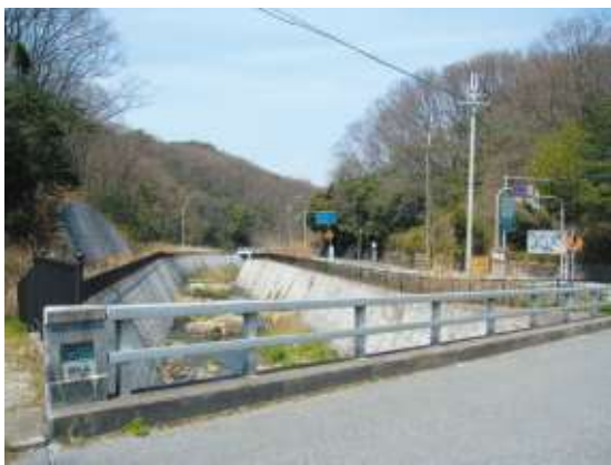
写真2. 羽衣橋 両岸が護岸壁で固められています
